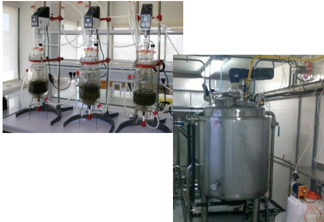
Planta piloto de biogas
