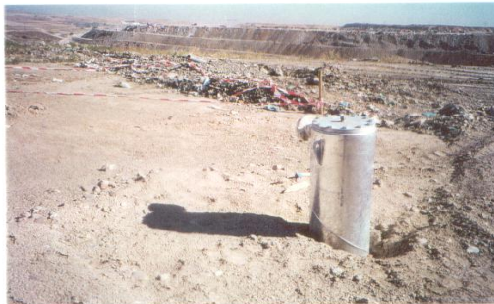
SELLADO DEL POZO CON EL CABEZAL DE ACERO GALVANIZADO
