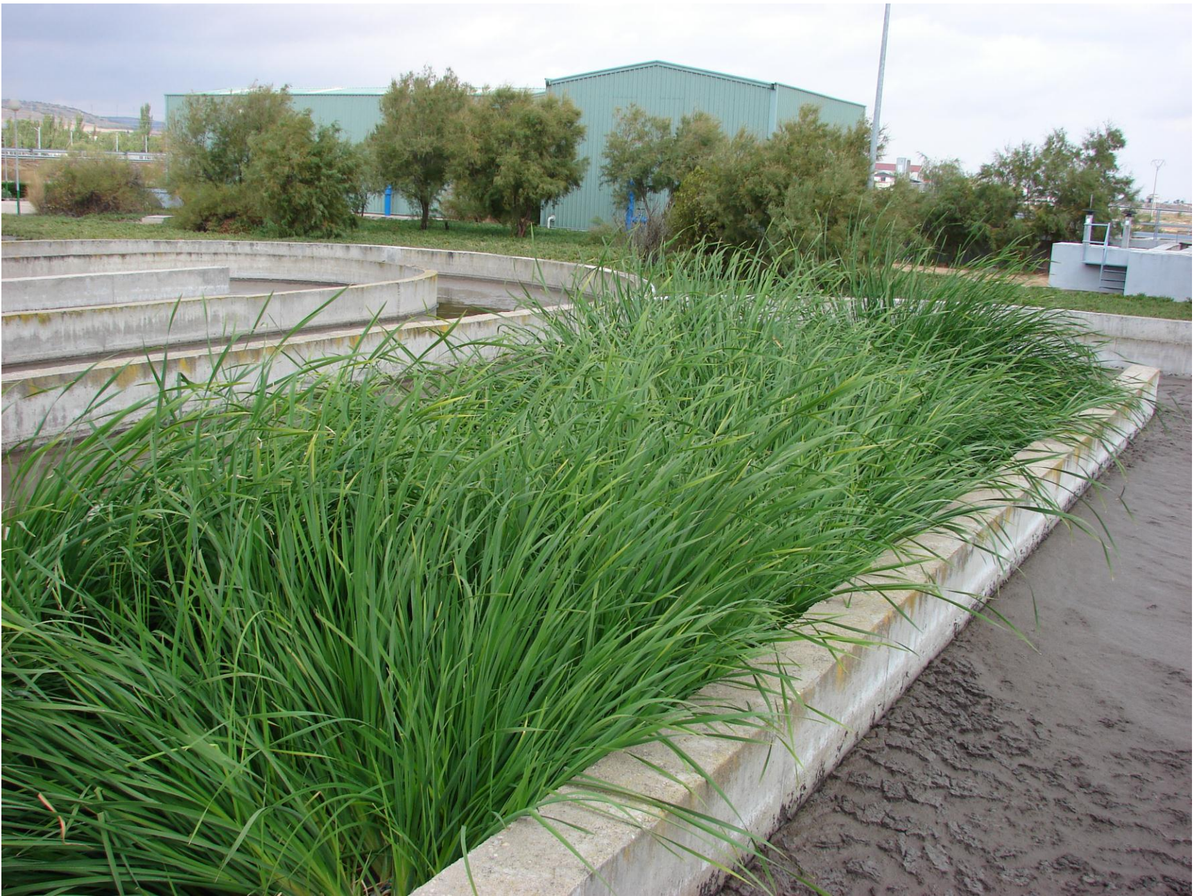
EDAR de tipo carrusel rehabilitada con Hidrolution FMF, en Villacañas (Toledo).
