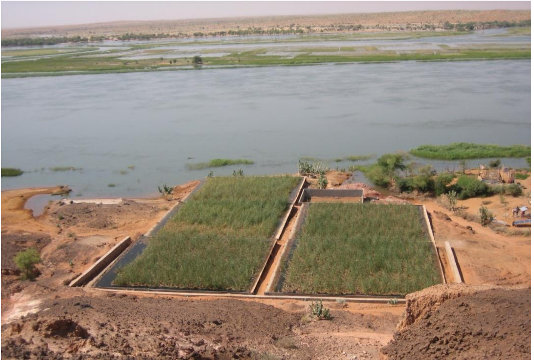
Potabilizadora Hidrolution FMF junto al río Níger en Tacharan (Mali).
