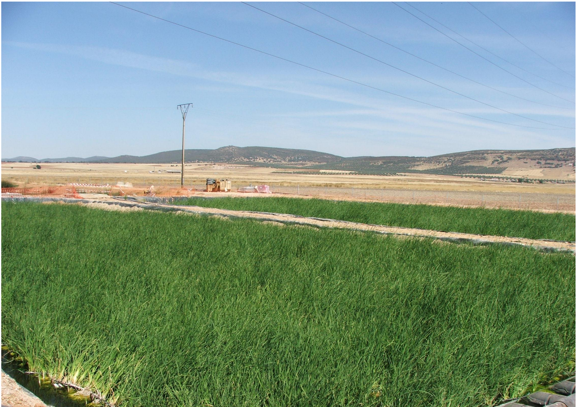
Edar Hidrolution FMF en Villamayor de Calatrava (Ciudad Real).
